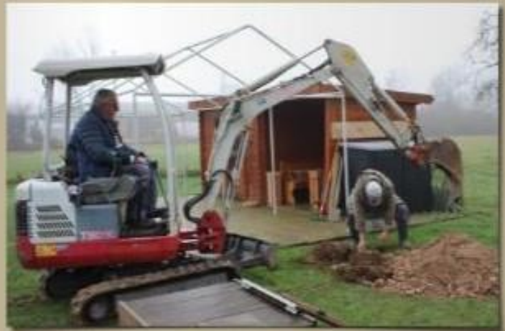
Am Silvestermorgen wurde unser Erdkühlschrank von Martin und Stephan eingebaut.
